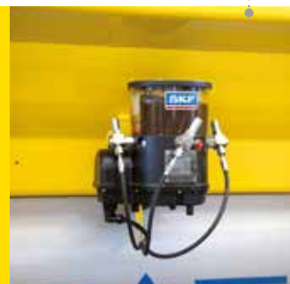
06 Système de graissage centralisé
