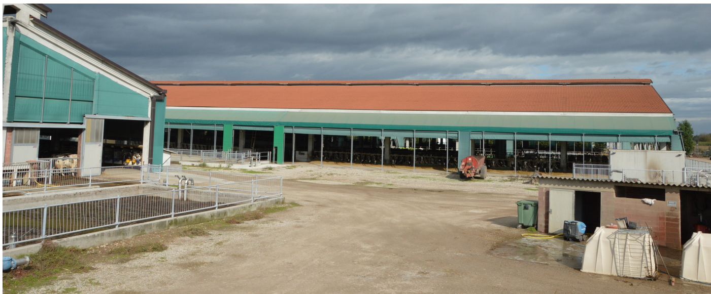
L'azienda Canili è stata sottoposta a una serie di ampliamenti e ristrutturazioni nel corso degli ultimi anni
